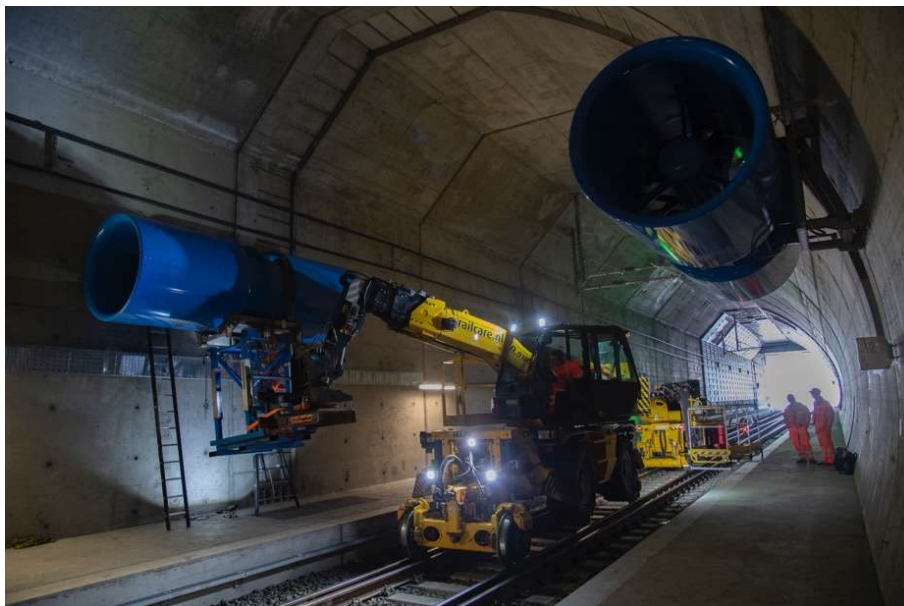
Obrázek 9: Příklad umístění ventilátorů (Ceneri tunel, Švýcarsko)
