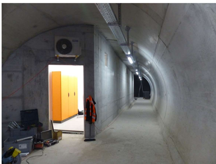
Obrázek 12: Technická místnost s HVAC jednotkou (Boezberg tunel, Švýcarsko)
