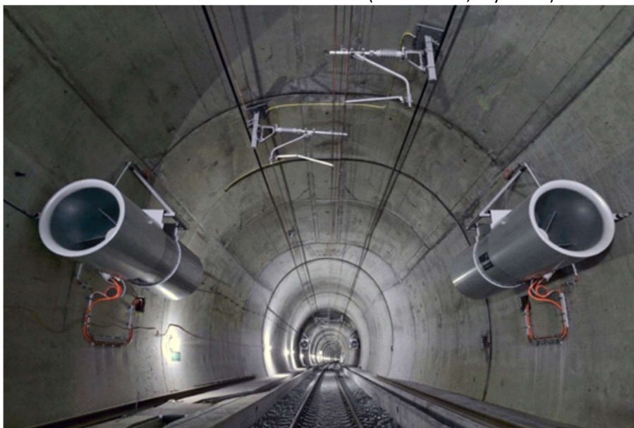
Obrázek 10: Další příklad umístění ventilátorů v železničním tunelu (Tel-Aviv Jerusalem High Speed Rail, Israel)
